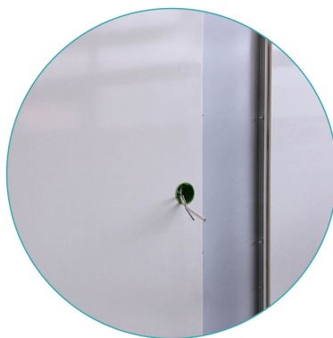
Odkrytý instalační sloupek a elektroinstalace
