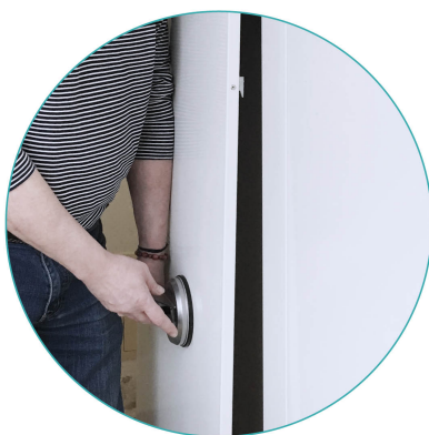
Jednoduchá demontáž instalačního panelu
