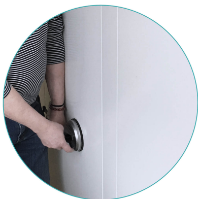
Jednoduchá demontáž instalačního panelu
