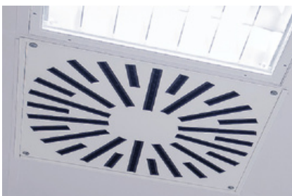
2) Vírivý anemostat s nastaviteľnými lamelami
