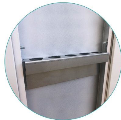
Odkrytý inštalačný stĺpik
