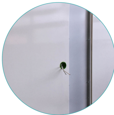
Odkrytý inštalačný stĺpik a elektroinštalácia
